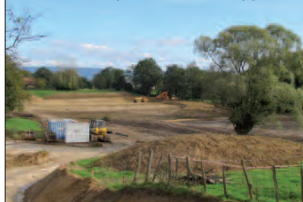
Les travaux du plan d'eau des Teppes
