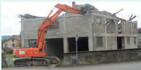
Démolition de l'atelier Piguet
